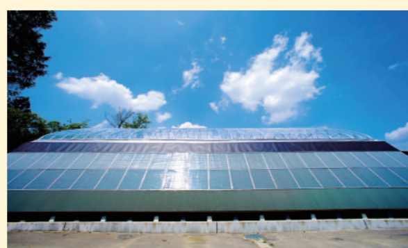
【南側傾斜面集熱】カルパリウム波板+フッ素樹脂フィルムの温室効果を利用して太陽熱を外気を暖めます。集熱空気を4台のファンで倉庫に押し込んでいます。集熱モードでは常に倉庫内はプラス圧に保たれます。
