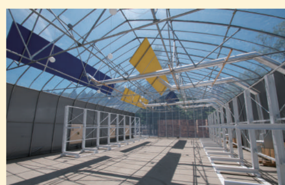
【屋内集熱パネル】温室フレームに南側天空を見上げる4枚の集熱パネルを設置、倉庫上部空間の空気をさらに太陽熱で温めて相対湿度を低くして循環しています。
