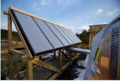
太陽熱で外気をあたため、乾燥した温風を作り出します。
