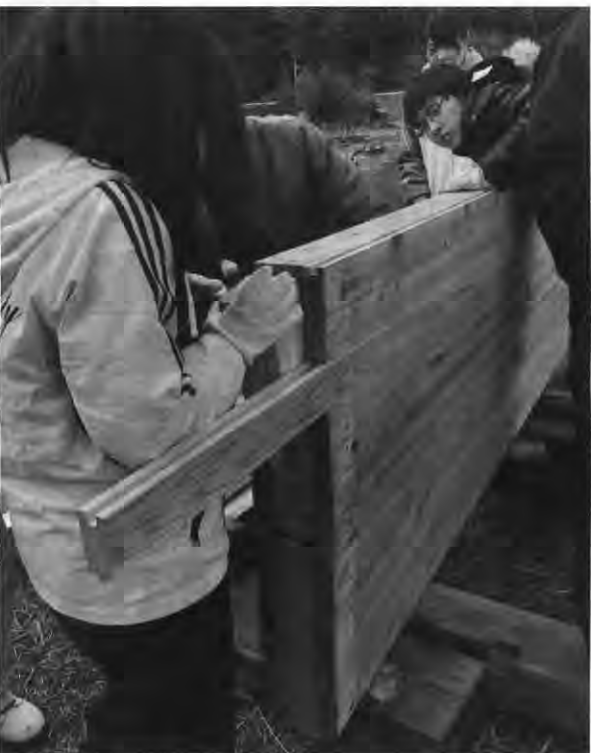
【写真2】 移築の為に仮設公民館のウッドパネルが丁寧に修繕される(写真提供:東海大学チャレンジセンター)
