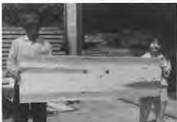
工期短縮の為に外壁パネルを工場で生産
