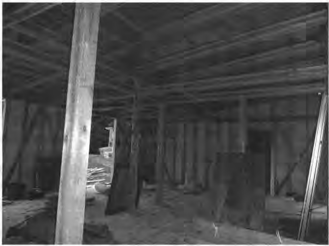
【写真1】 移築に向けて解体が進む木造災害公営住宅
