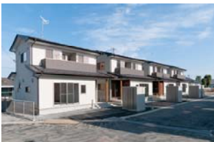
木造災害公営住宅（登米市）
