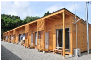
木造応急仮設住宅（南三陸町）
