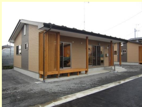
登米市に建てられた木造の災害公営住宅。
