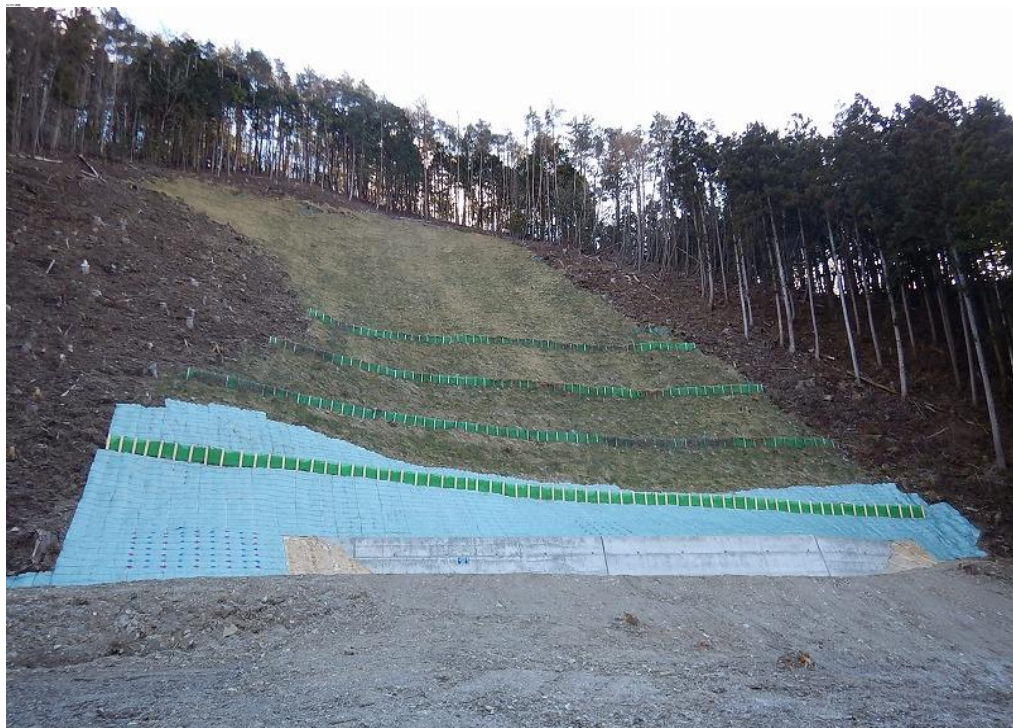
力畑地区予防治山工事（登米市東和町米川地内）
