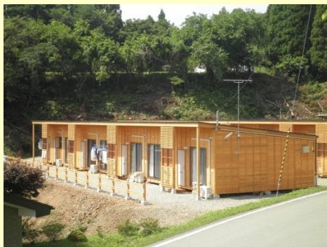
震災直後に建てられた南三陸町の木造応急仮設住宅。
