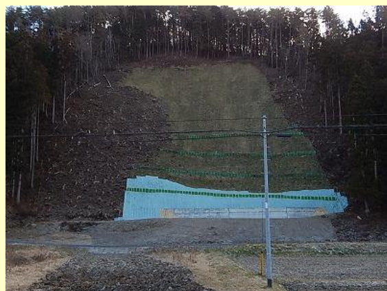
施工後(工事完成)
